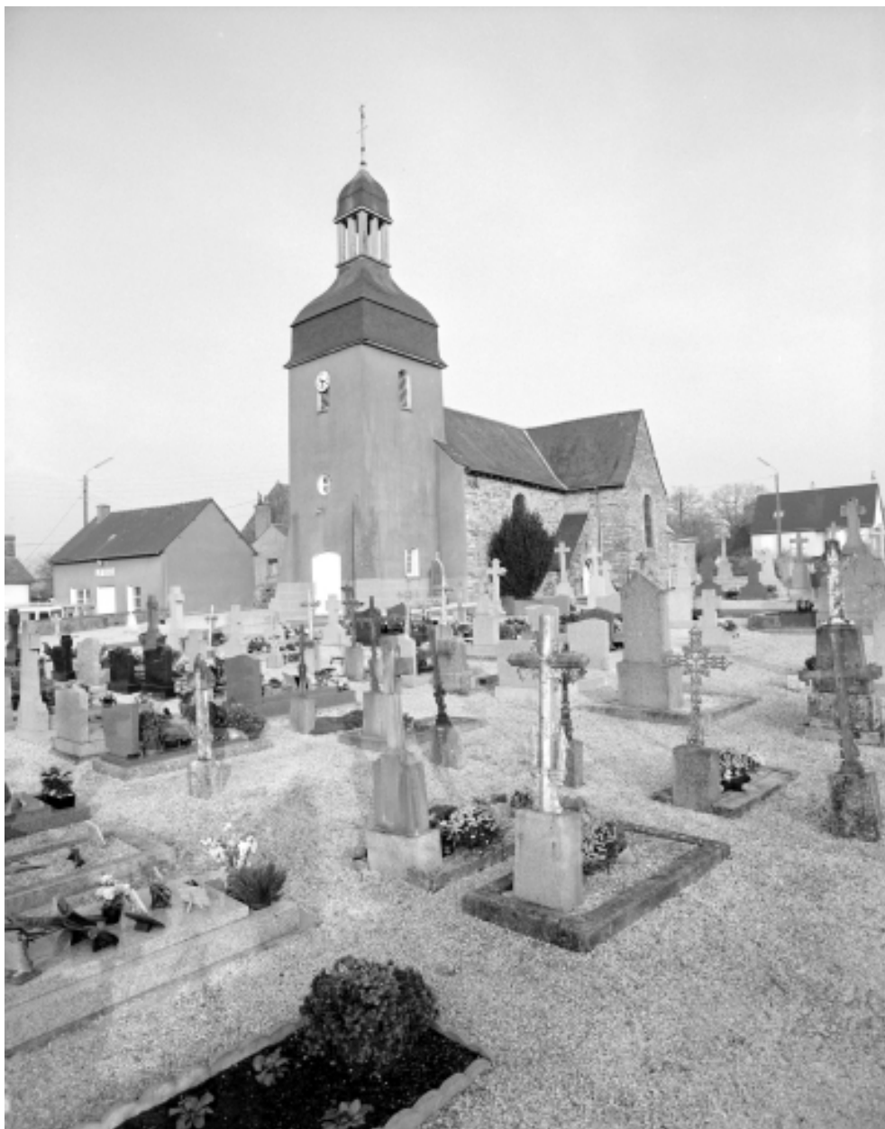
Elévation Ouest : vue de situation
