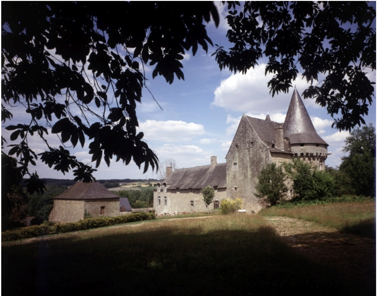
Vue générale prise du sud-ouest (état en 1984)
