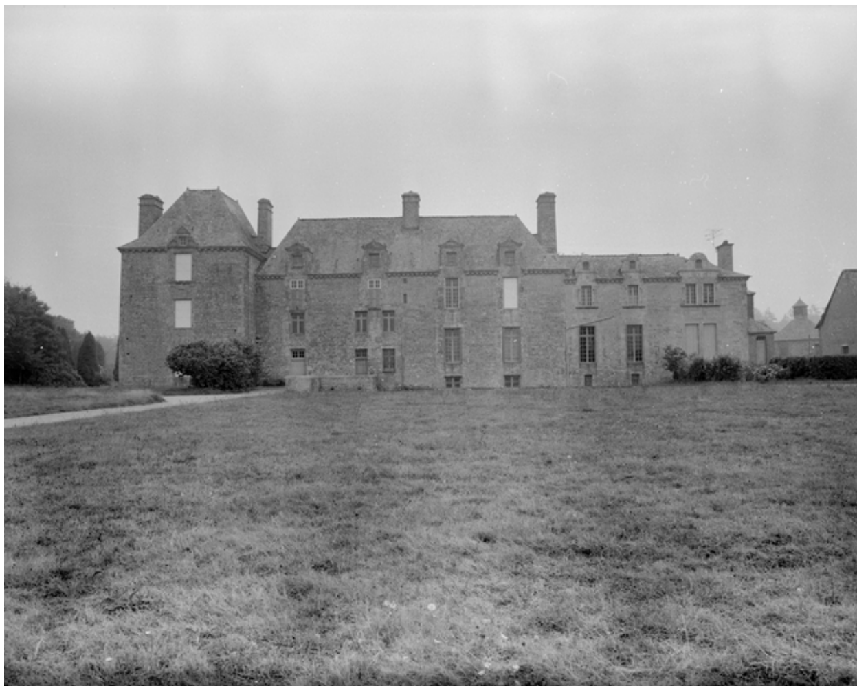
Logis, élévation postérieure : vue générale prise du nord-ouest
