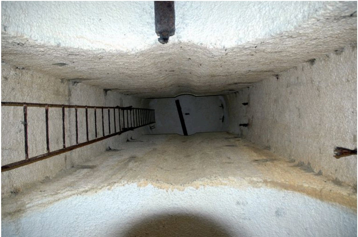
Vue de la pointe des Espagnols : puits du monte-charge du magasin à poudre sous roc
