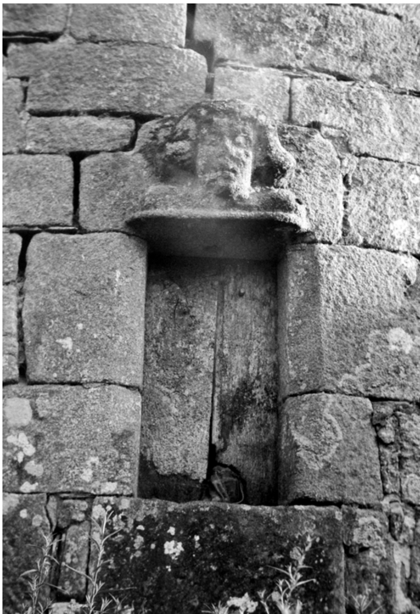
Façade nord, tourselle : détail de la fenêtre
