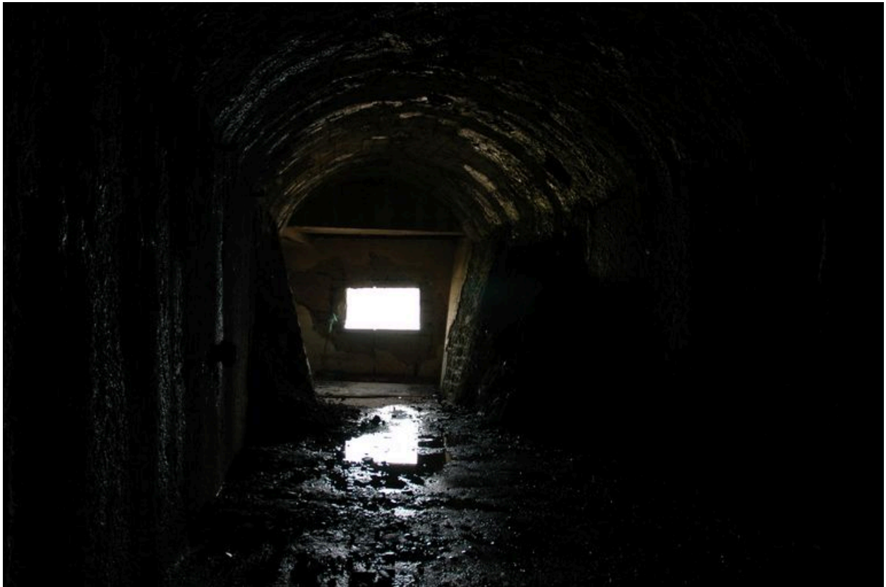
Vue de l'une des deux chambres de tir (état en 2005)
