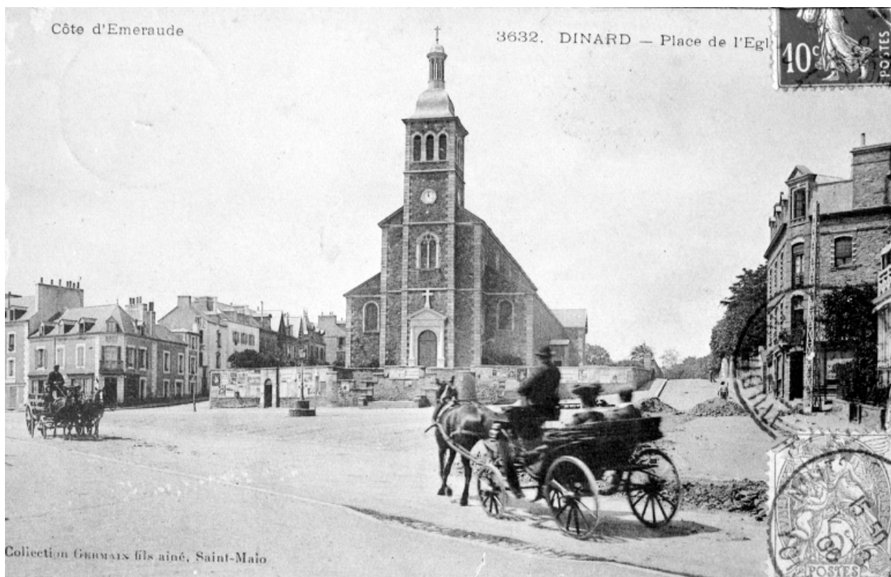
Carte postale ancienne - Elévation Est : vue de situation.
