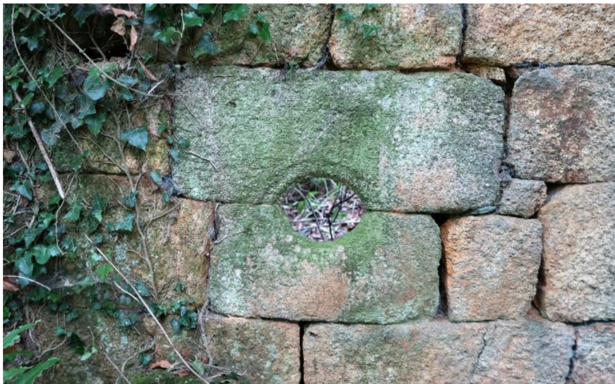
Vue de détail de la tour circulaire : ouverture de tir de forme ovoïde
