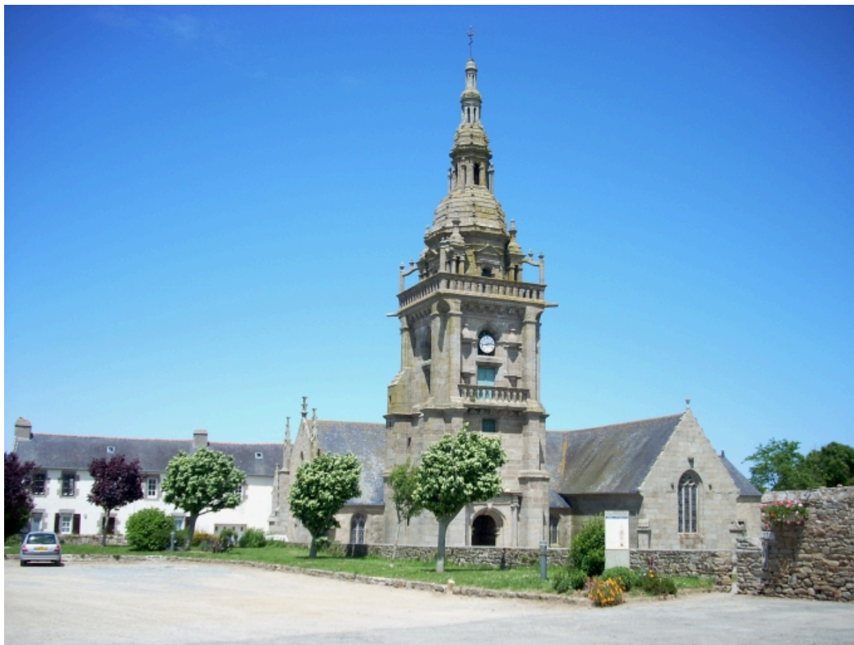
Lampaul-Ploudalmézeau, église paroissiale : vue générale sud-ouest
