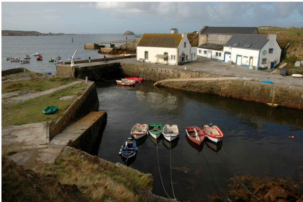
Vue du port-abri de Lampaul
