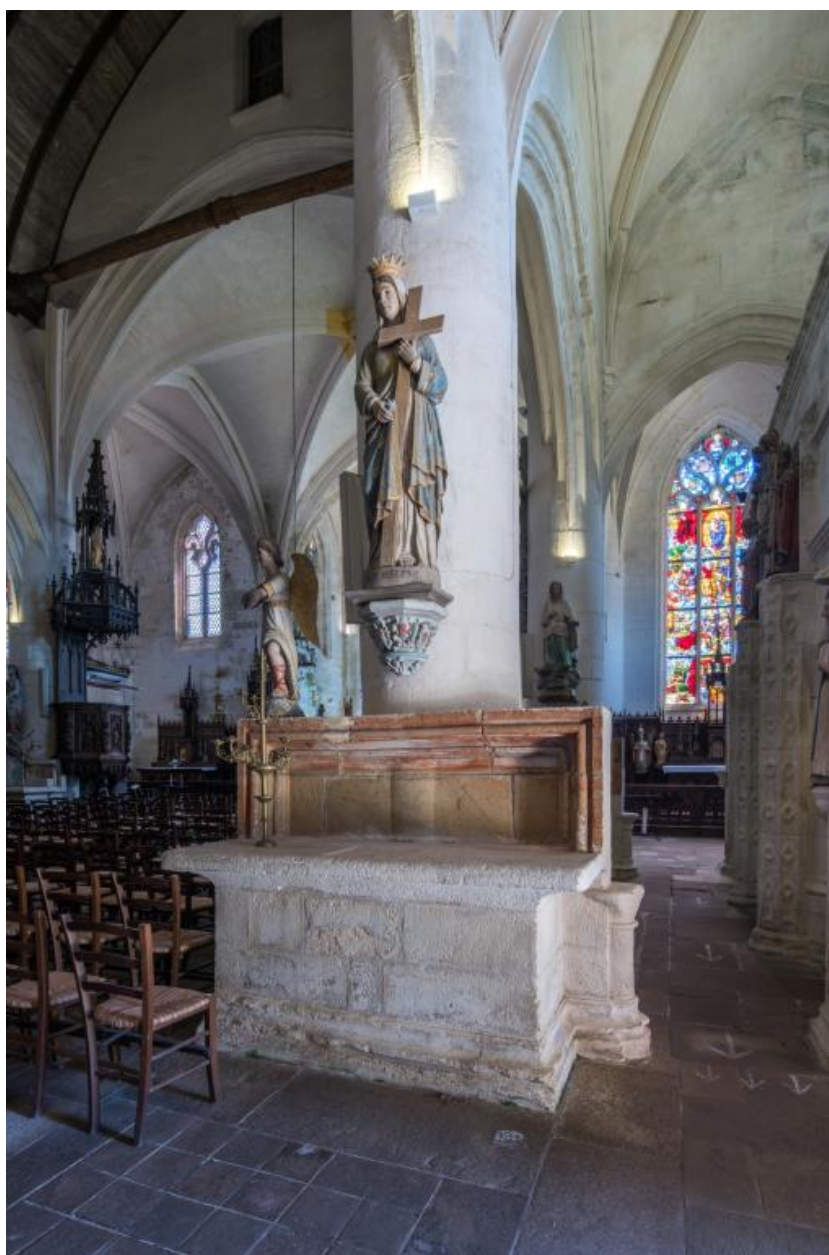
Vue de détail : pilier de la nef séparant le vaisseau central du bas-côté sud.
