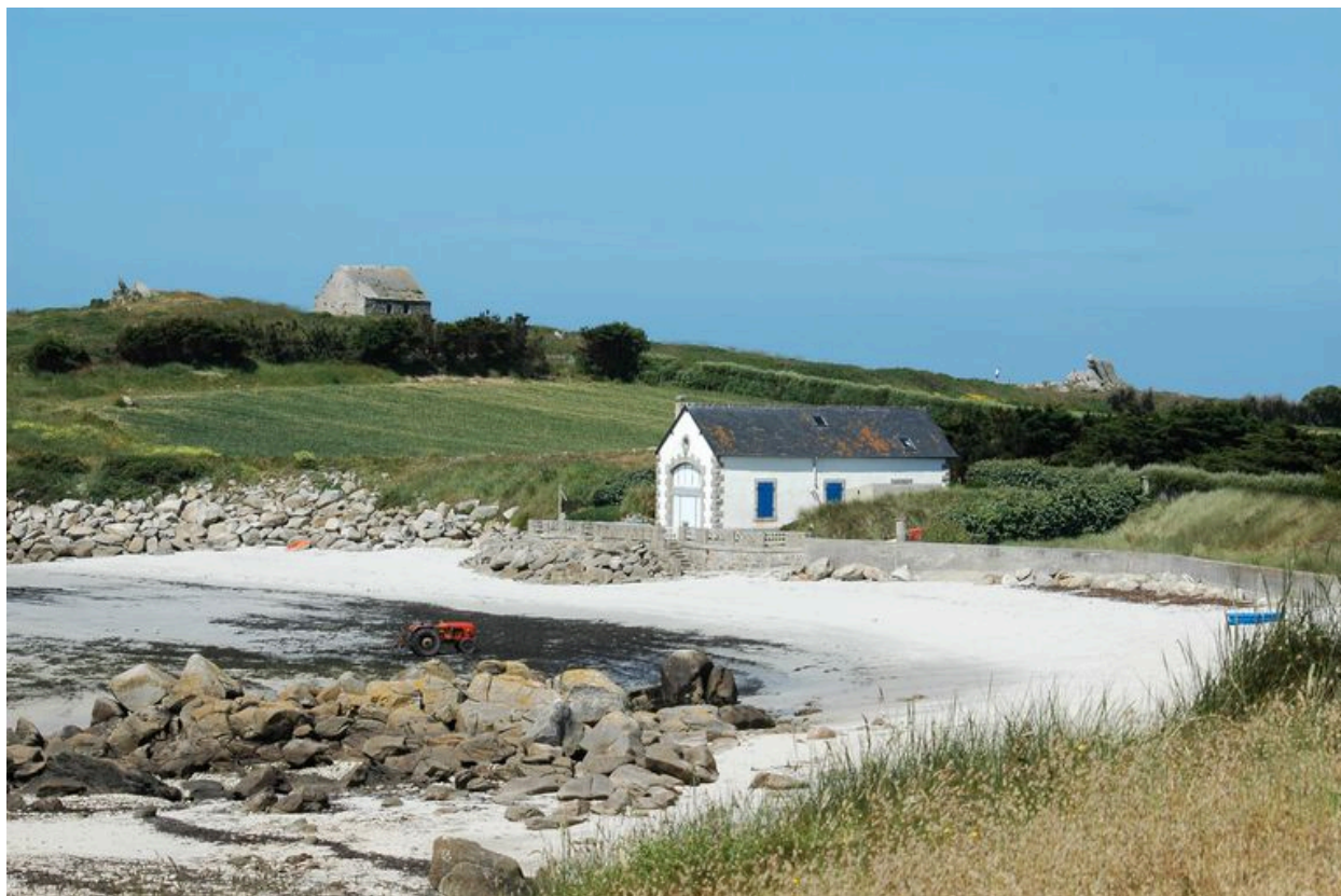
Vue de situation du corps de garde (18e siècle). Au premier plan : l'ancien abri du canot de sauvetage
