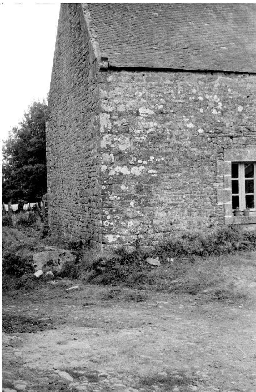
Ferme 49 (état en 1969)
