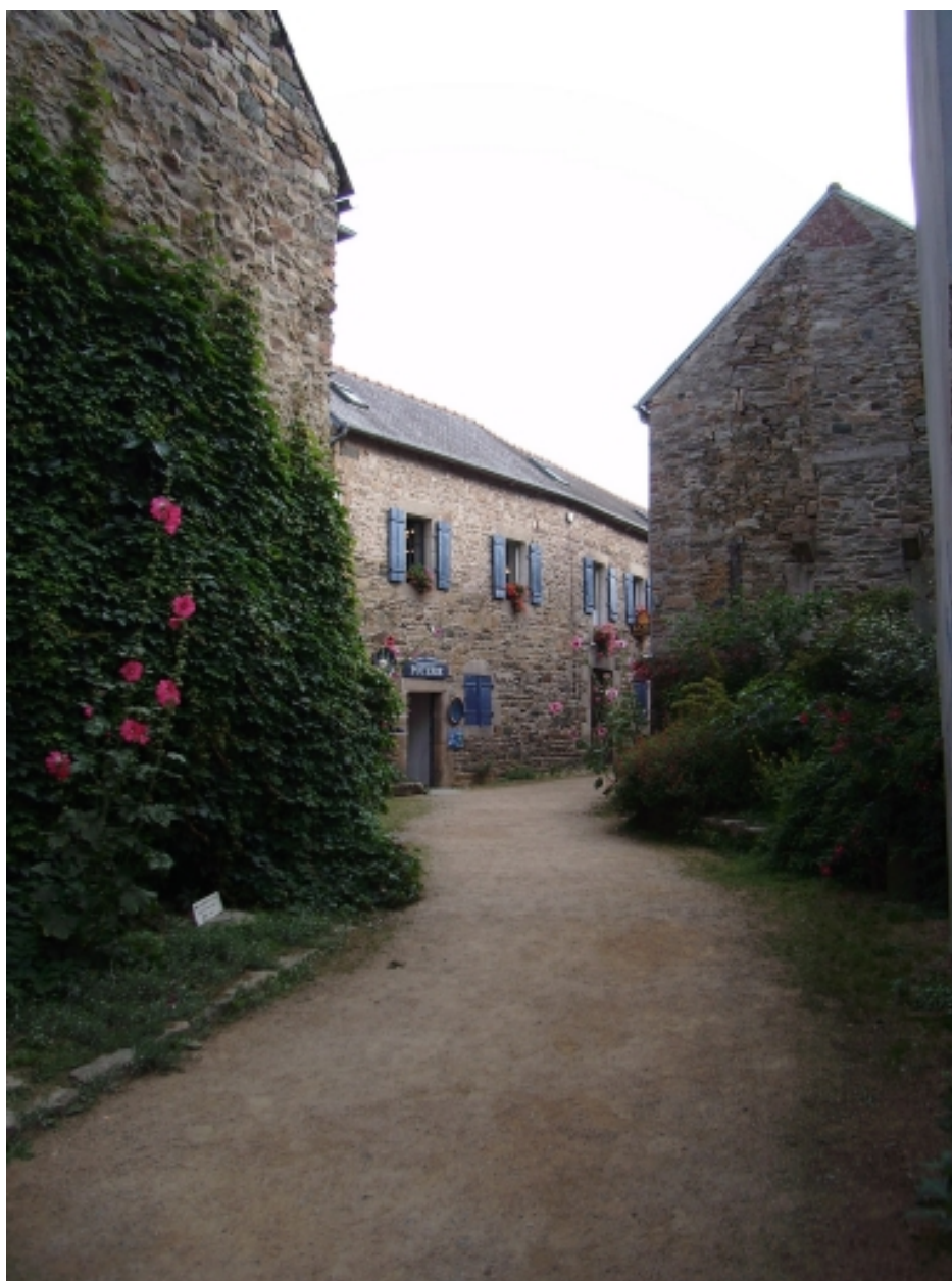
Paimpol, le Centre-Ville. Maisons disposées autour d'une cour intérieure attenante à la rue des Huit-Patriotes
