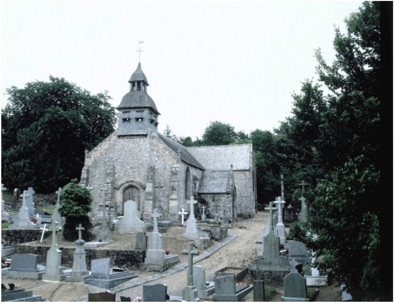
Elévation Ouest : vue générale
