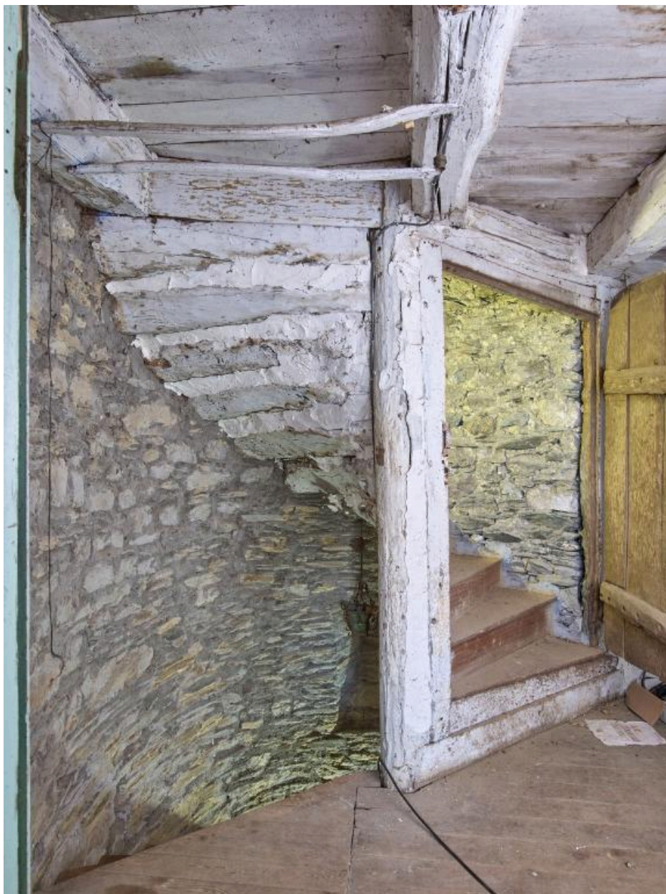
Logis 1673. Escalier en vis en demi hors-oeuvre. Volée de marches menant au comble. Vue depuis l'étage
