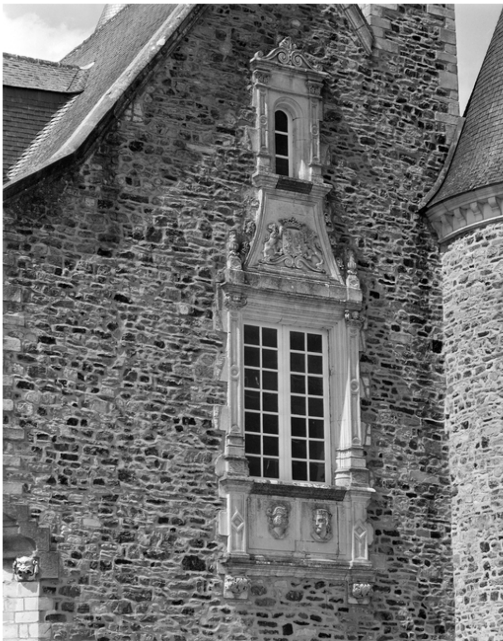
Elévation principale : lucarne nord.
