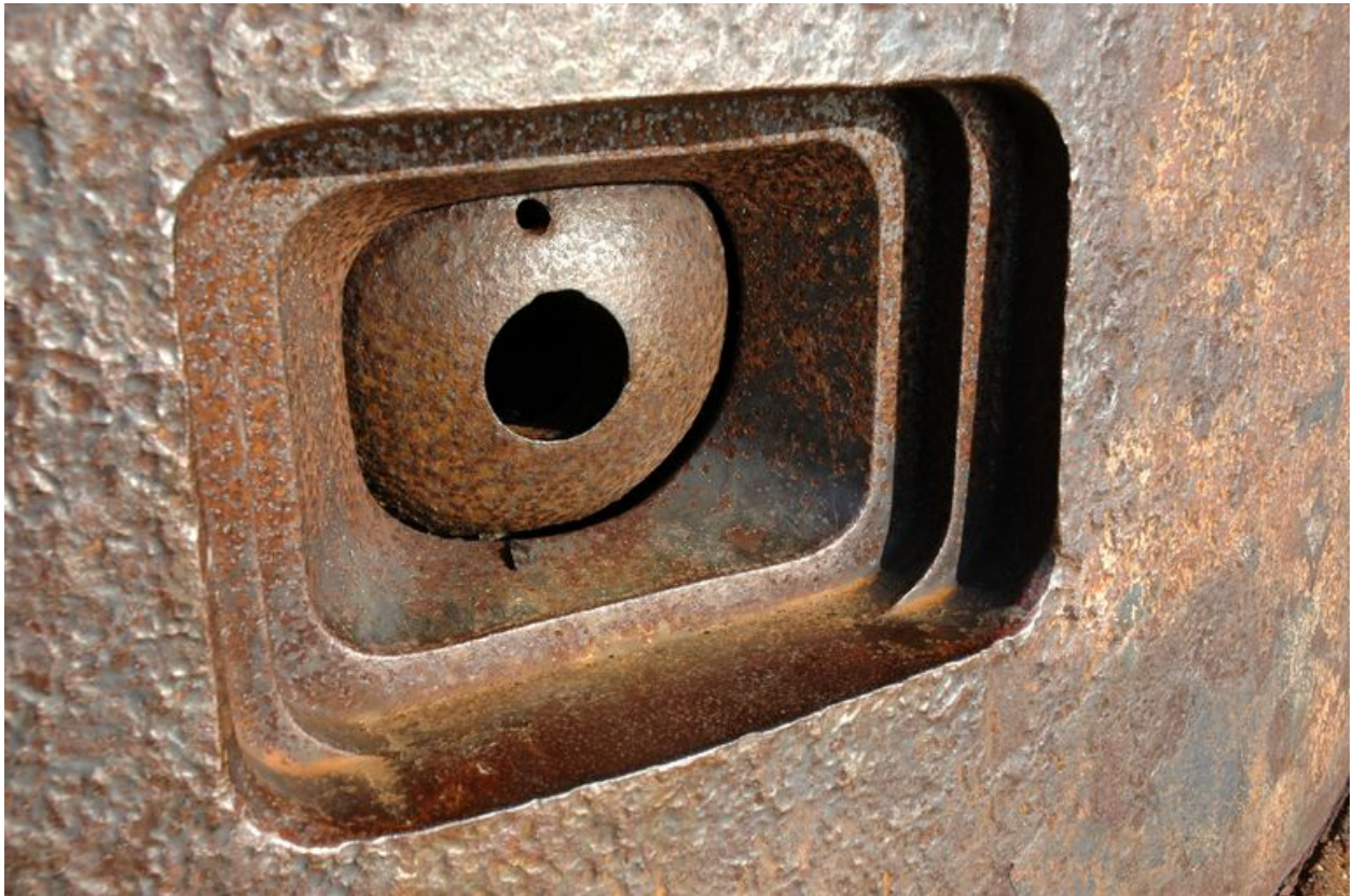
Cloche blindée implantée sur un bunker : détail de la rotule
