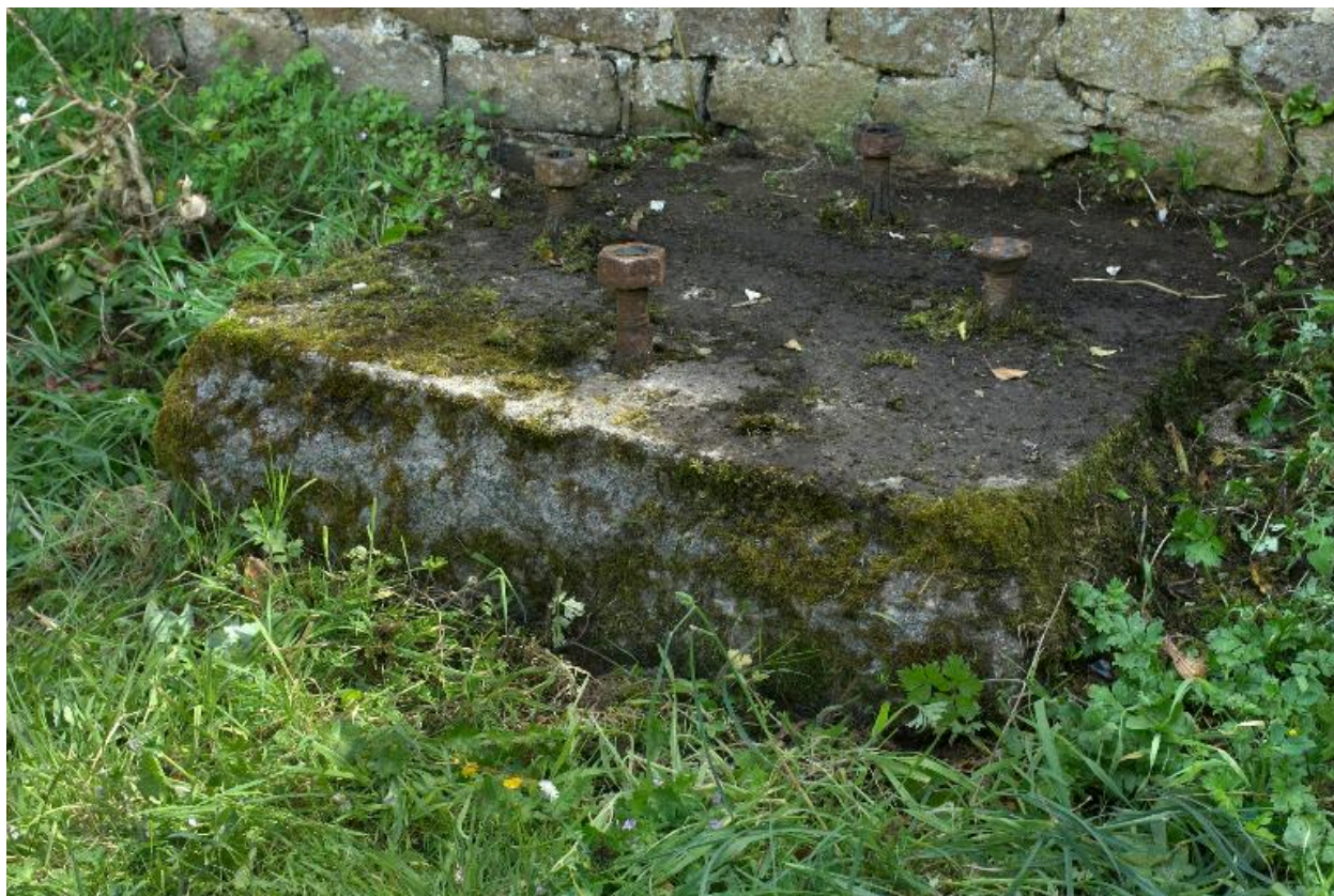
Plouzané : vue du fort du Dellec, dé et boulons de sellette
