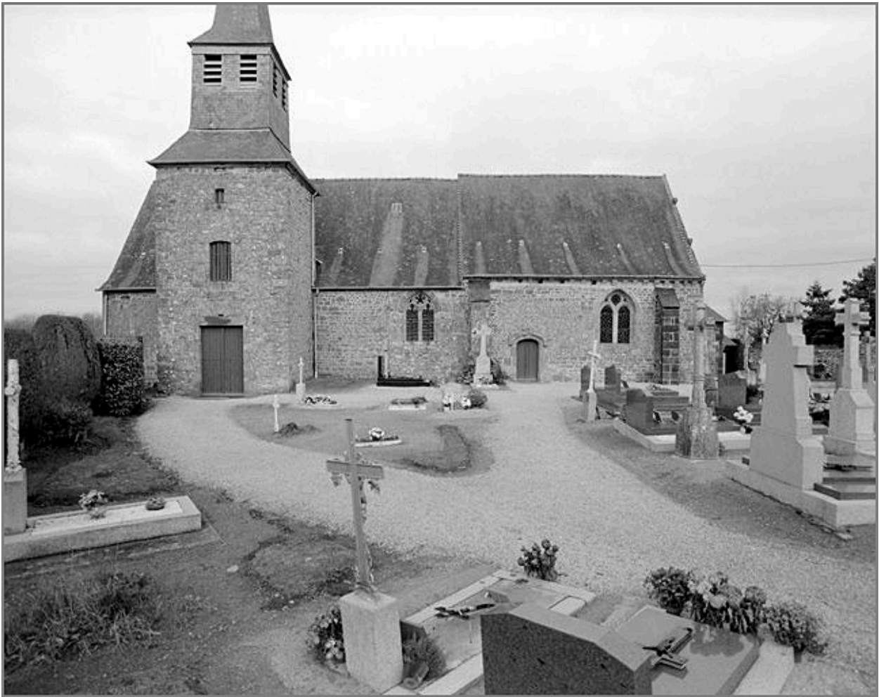
Elévation Sud : vue générale
