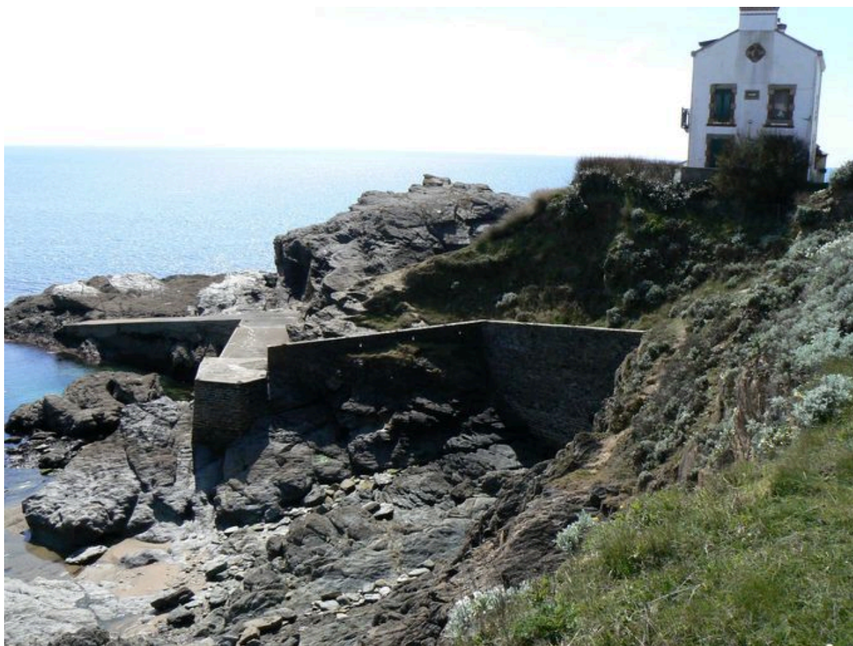
Vue générale de la cale des Grands-Sables
