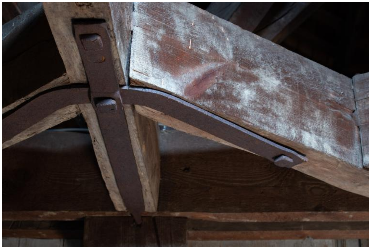
Charpente au grenier
