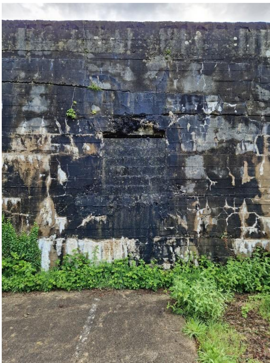
Vue de détail de l'élévation ouest : ouverture à mi-hauteur (murée par des parpaings). Autour du bunker se trouve une vaste aire bétonnée
