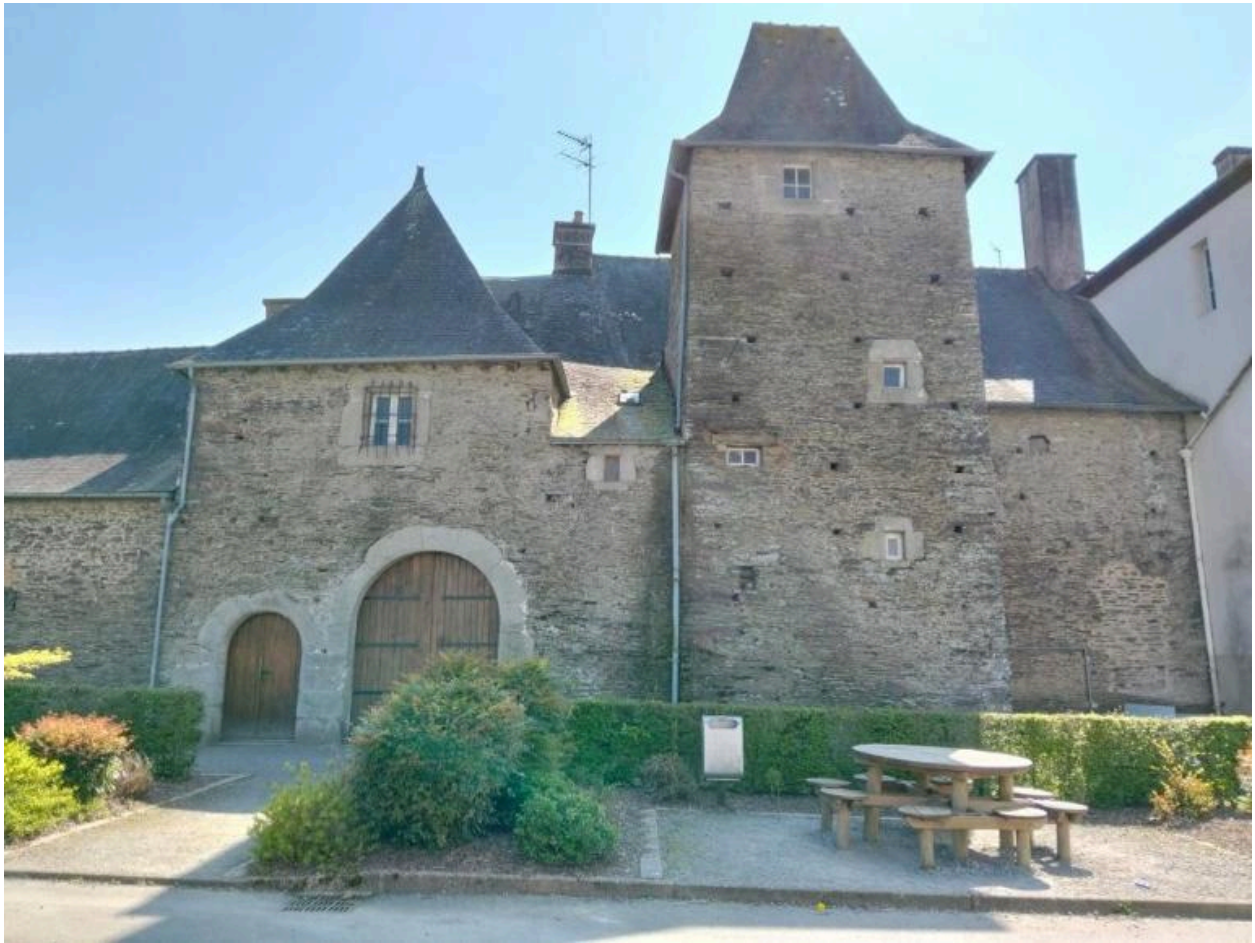
Façade nord, vue générale
