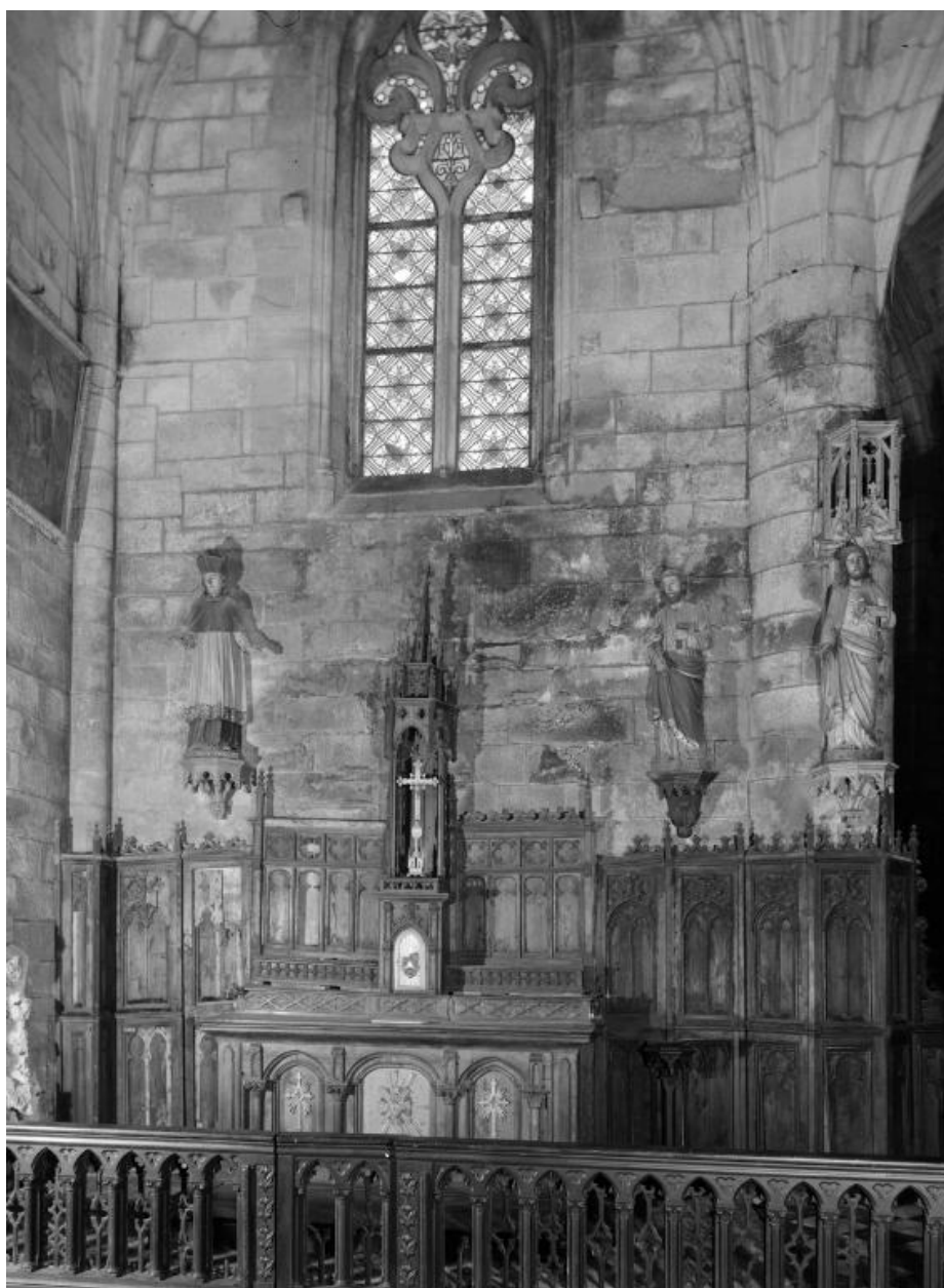
Vue d'ensemble du mur est du bras nord du transept.
