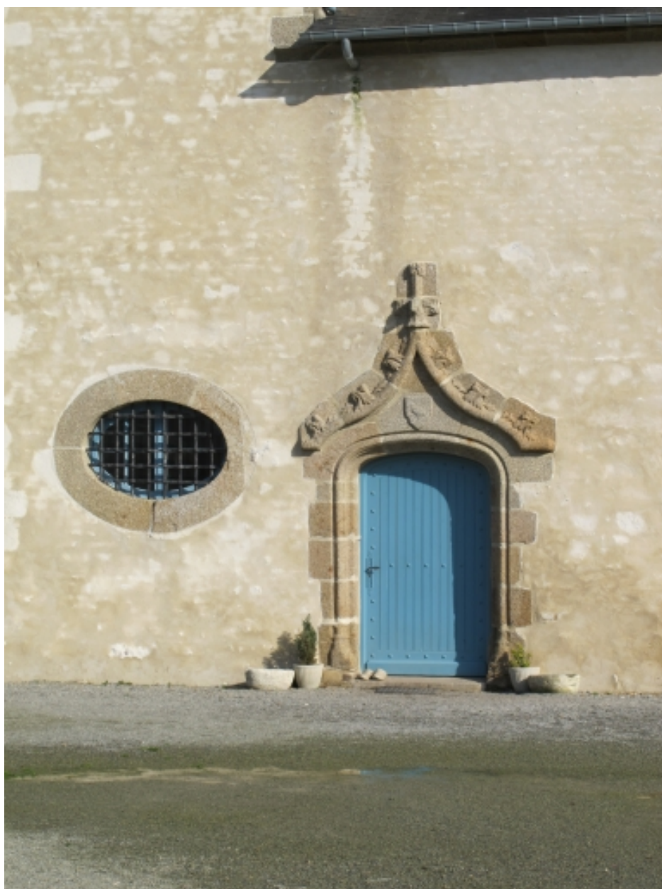
Détail de la porte du logis
