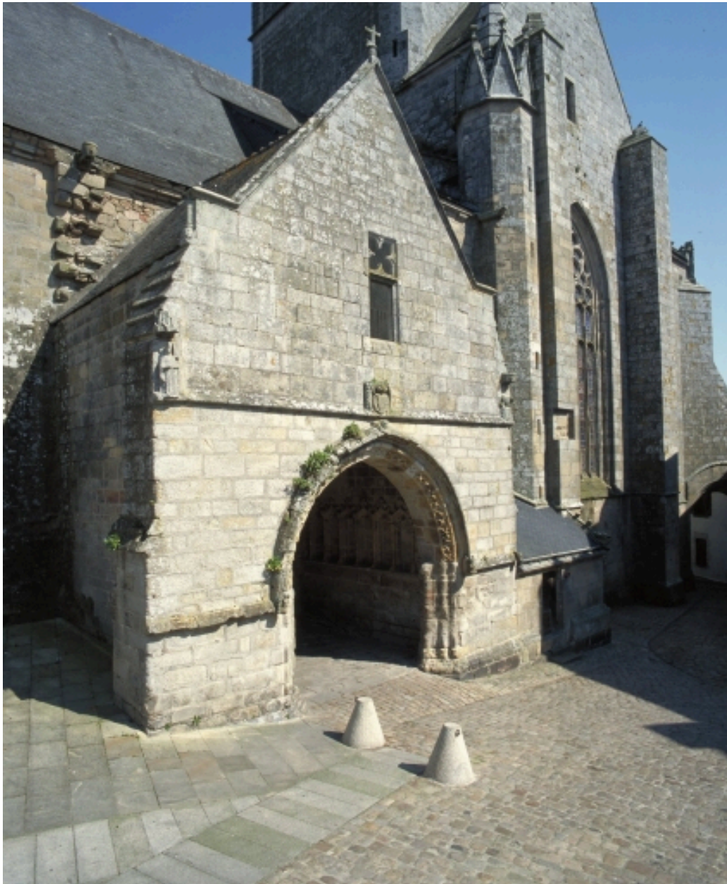
Porche sud, vue générale
