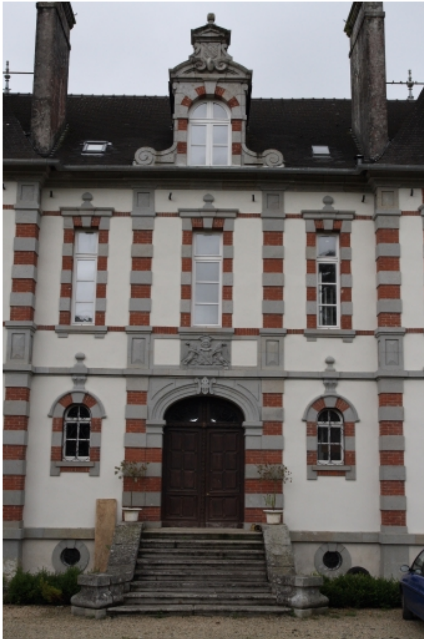
Elévation est, travée centrale
