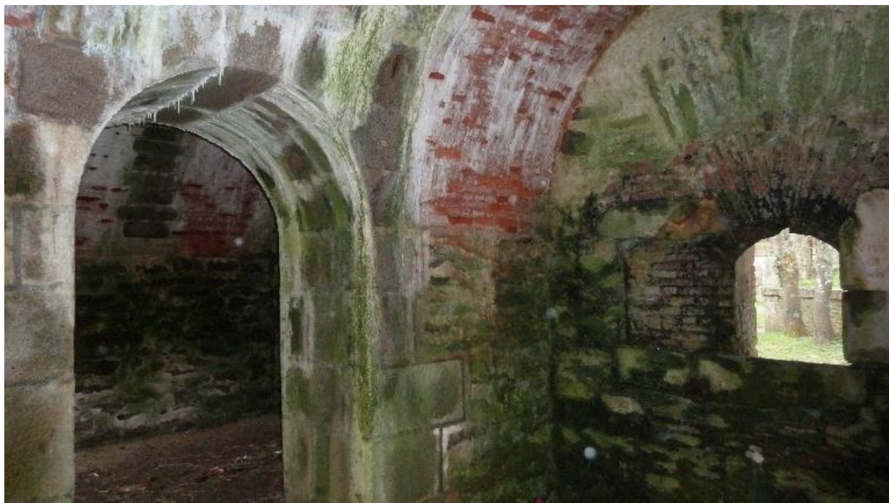
Le Palais, enceinte urbaine, réduit G, casemate d'artillerie.
