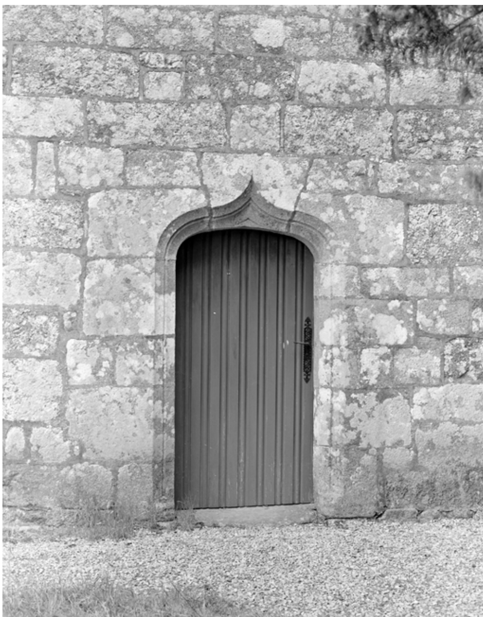
Nef, élévation sud : porte d'entrée
