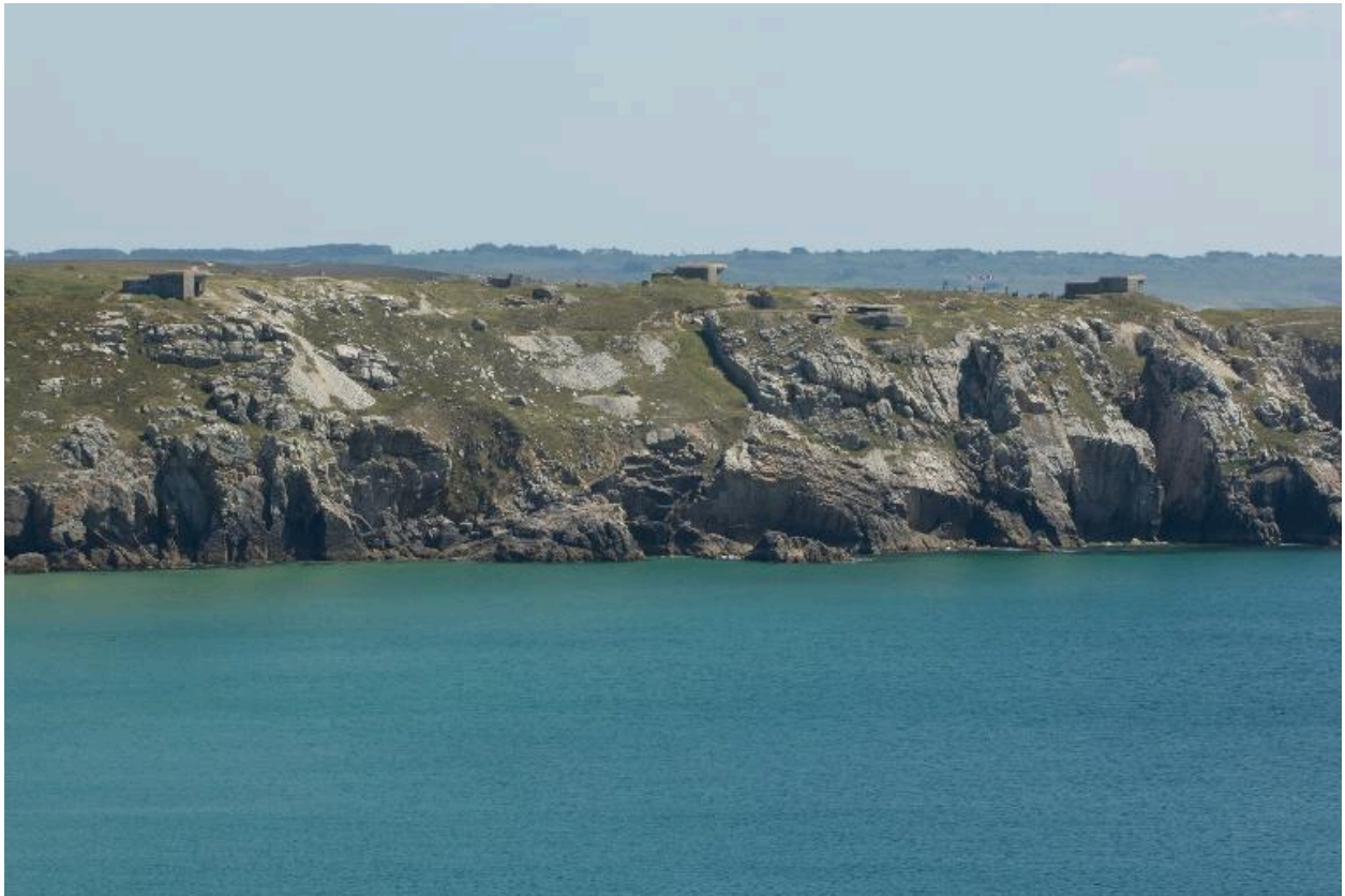
Vue de la batterie de Kerbonn depuis la pointe du Toulinguet : alignement de bunkers
