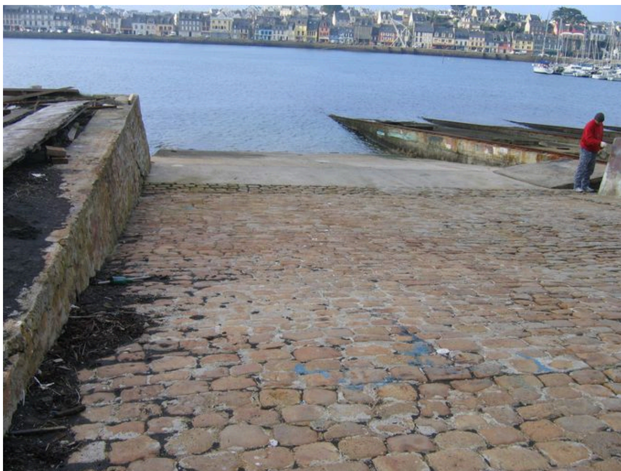
Vue générale de la cale des Viviers
