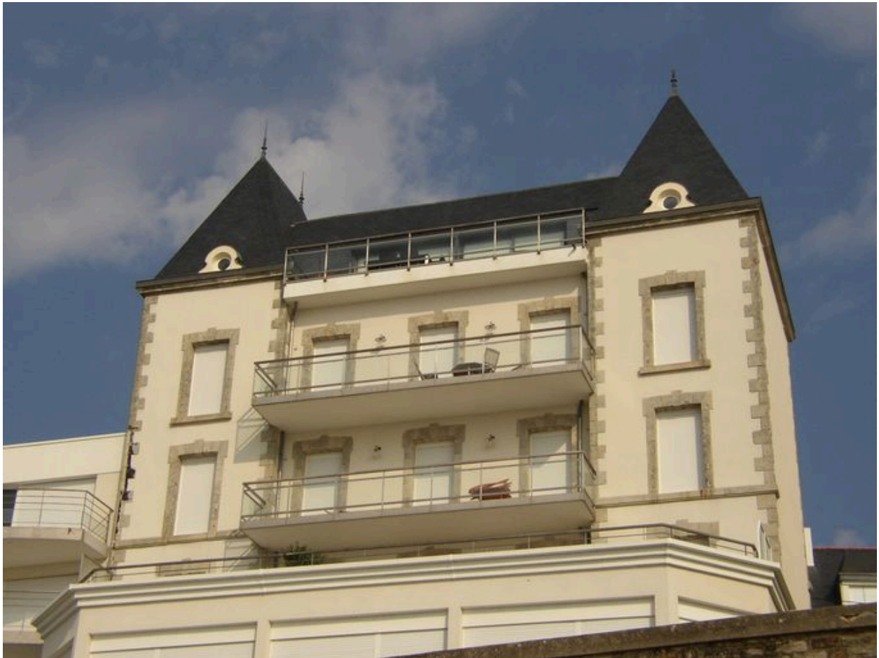
Etages supérieurs de la façade principale de l'ancien Hôtel des Bains
