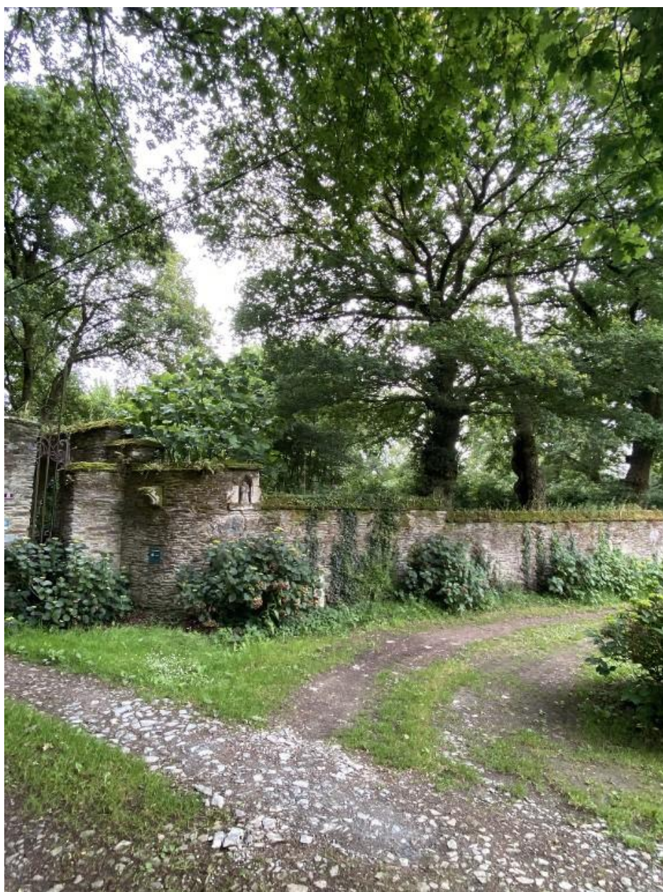
Ancien mur d'enceinte du domaine, vue nord
