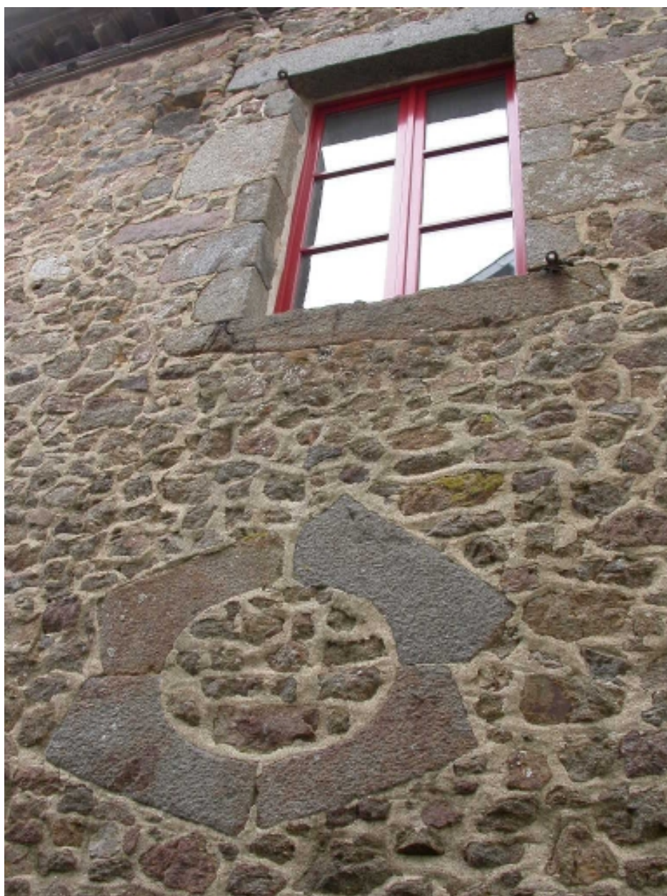
Oculus muré en façade ouest
