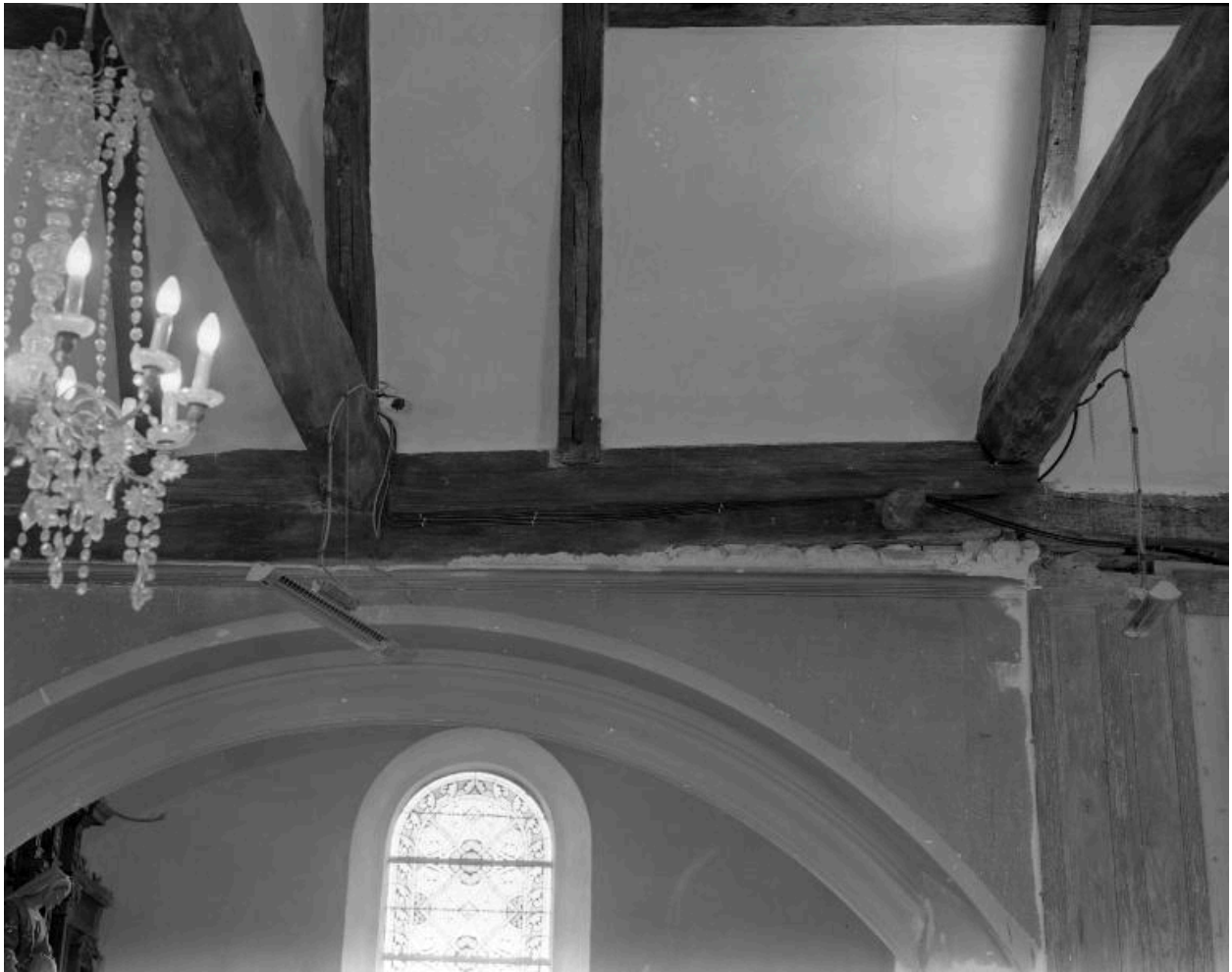
Vue intérieure, sablière de la nef, état vers 1980
