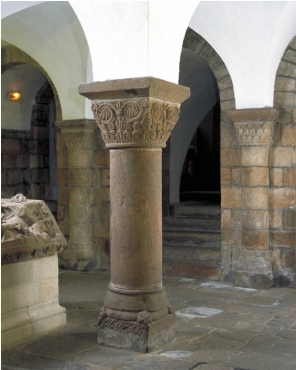
Crypte, travée nord, pilier ouest
