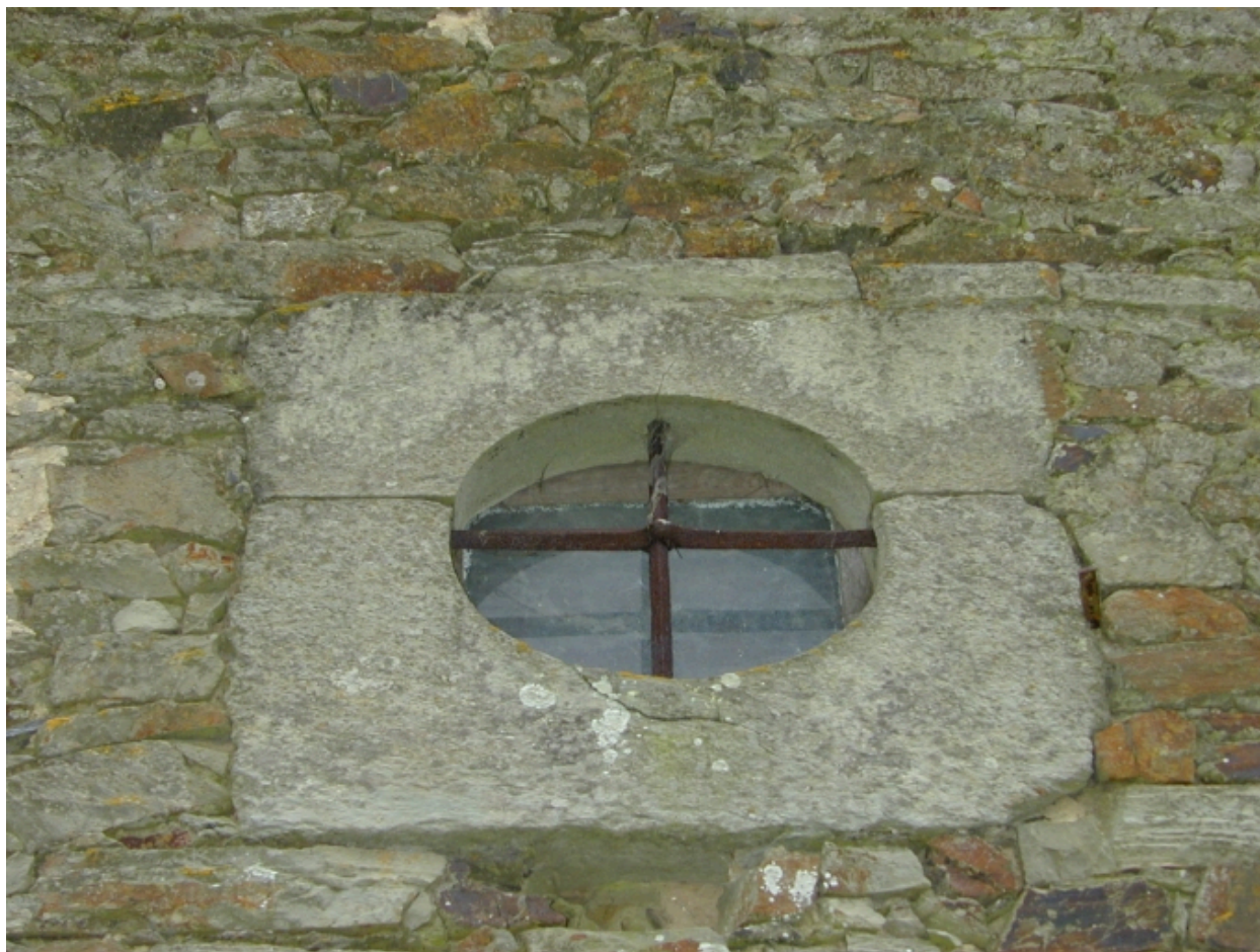
Communs, façade postérieure, oculus : détail
