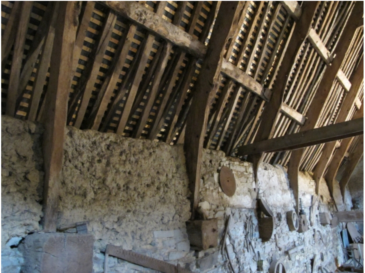
La grange, détail de la charpente
