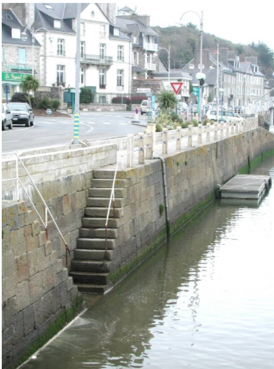
Double escalier du quai de Courcy
