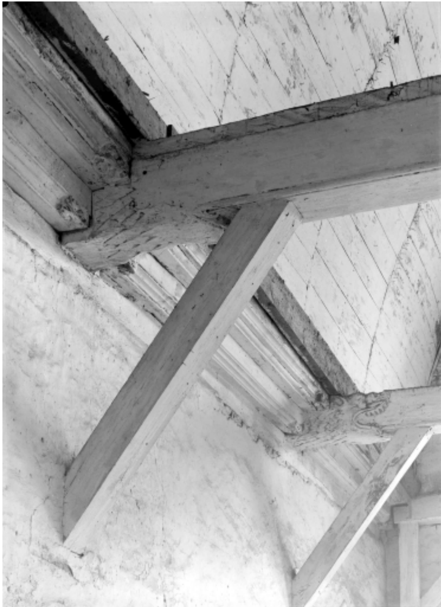
Bras nord du transept : détail des engoulants
