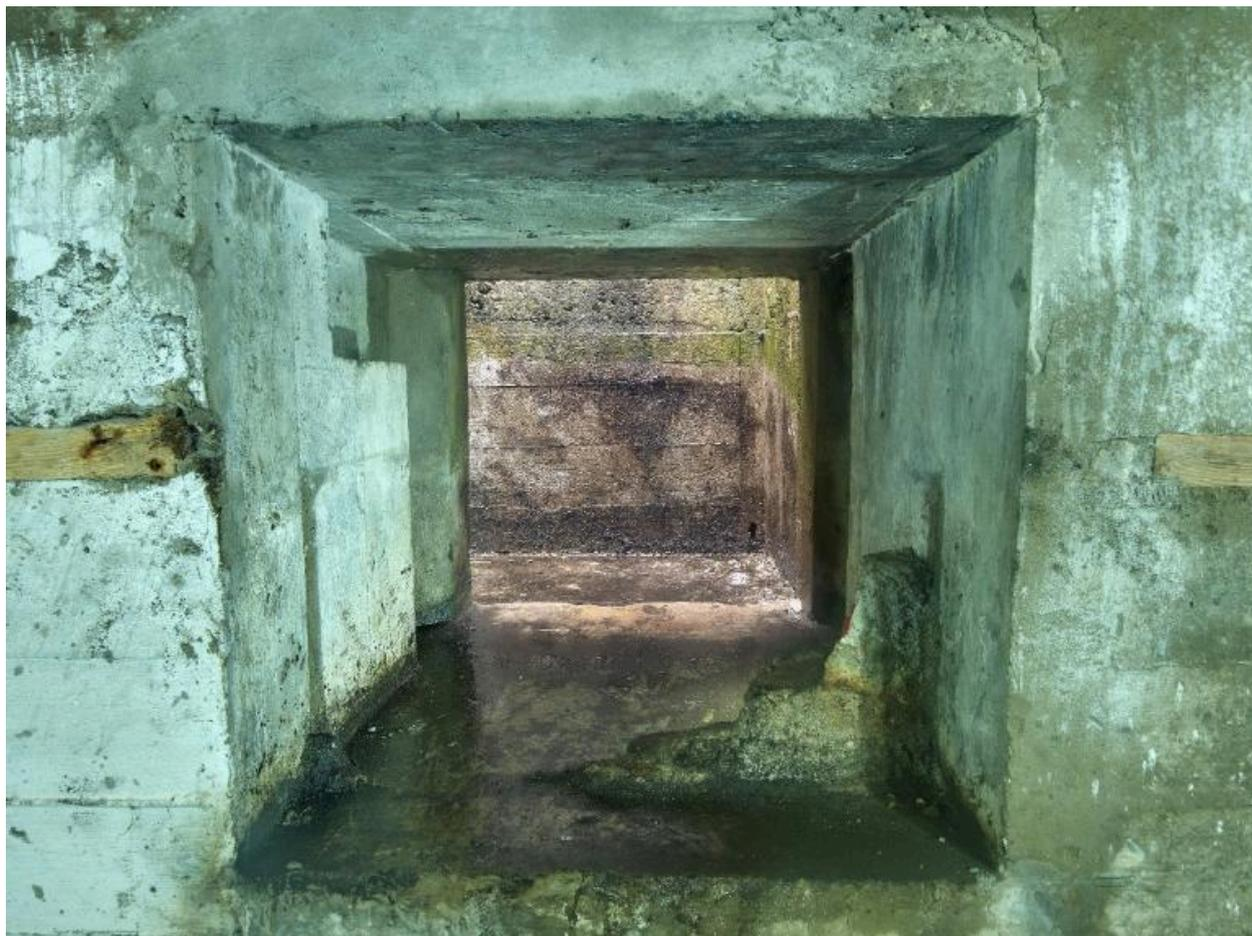
Vue de la sortie de secours de la salle de garde (mur ouest). Elle débouche dans un puits doté d'échelon. En temps de guerre, cette sortie de secours était fermée par une porte et son puits était comblé
