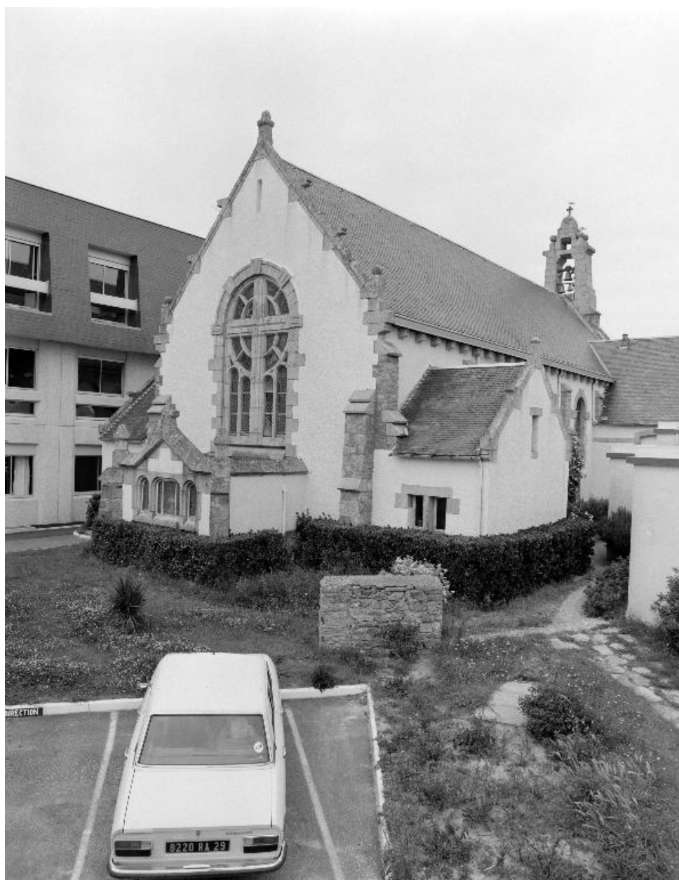
Perharidy - Centre hélio-marin : chapelle du sanatorium : élévation sud-ouest, vue générale
