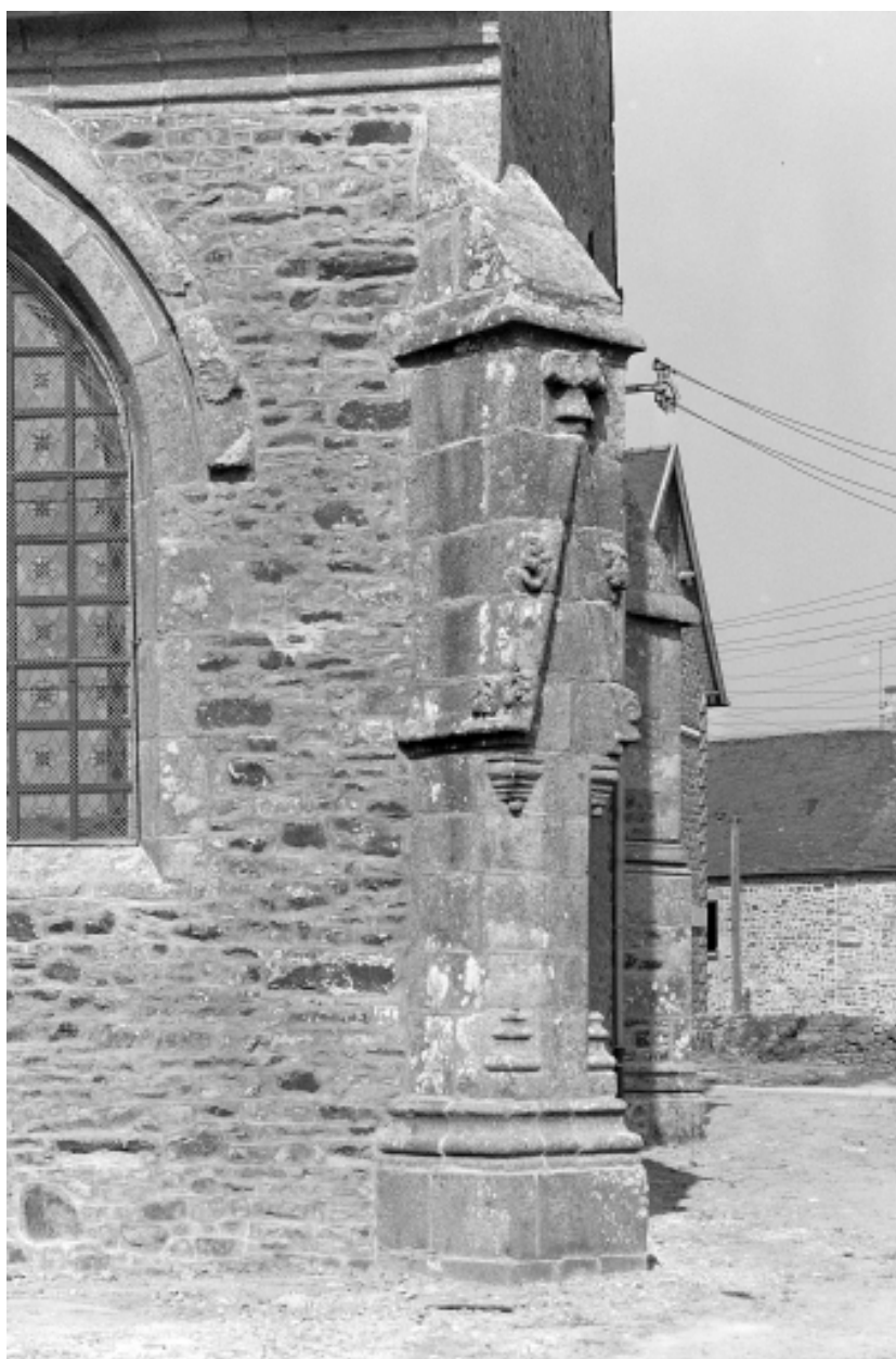
Façade sud, contrefort.
