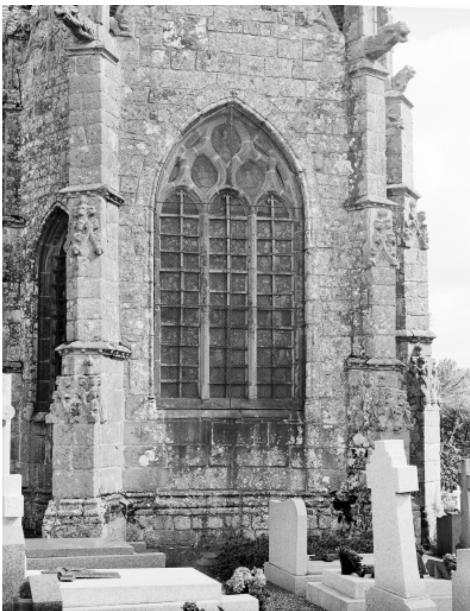
Elévation sud, chapelle saint-Yves : baie sud et contreforts.
