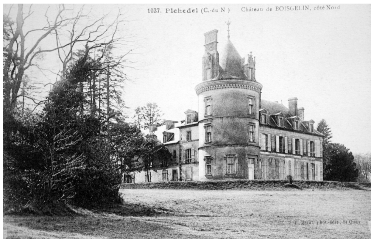
Vue générale, côté nord
