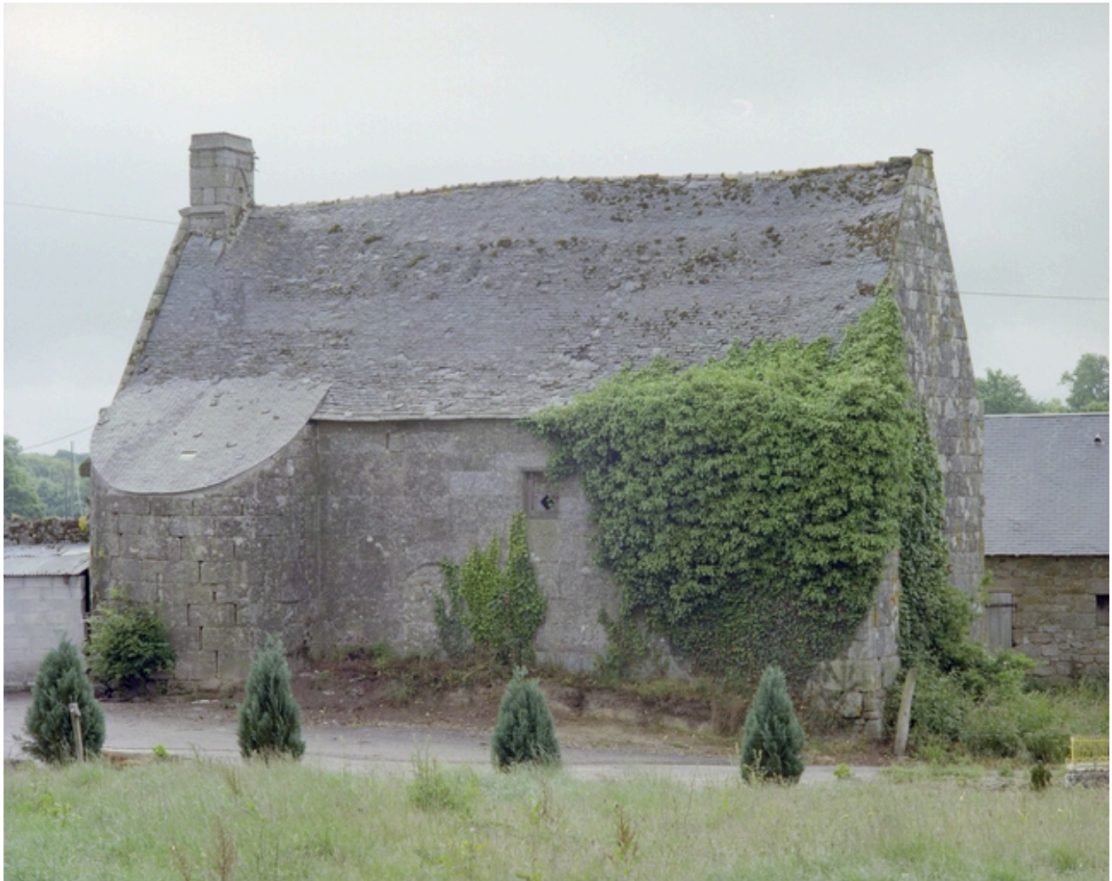
Vue générale de la façade postérieure avec tour d'escalier
