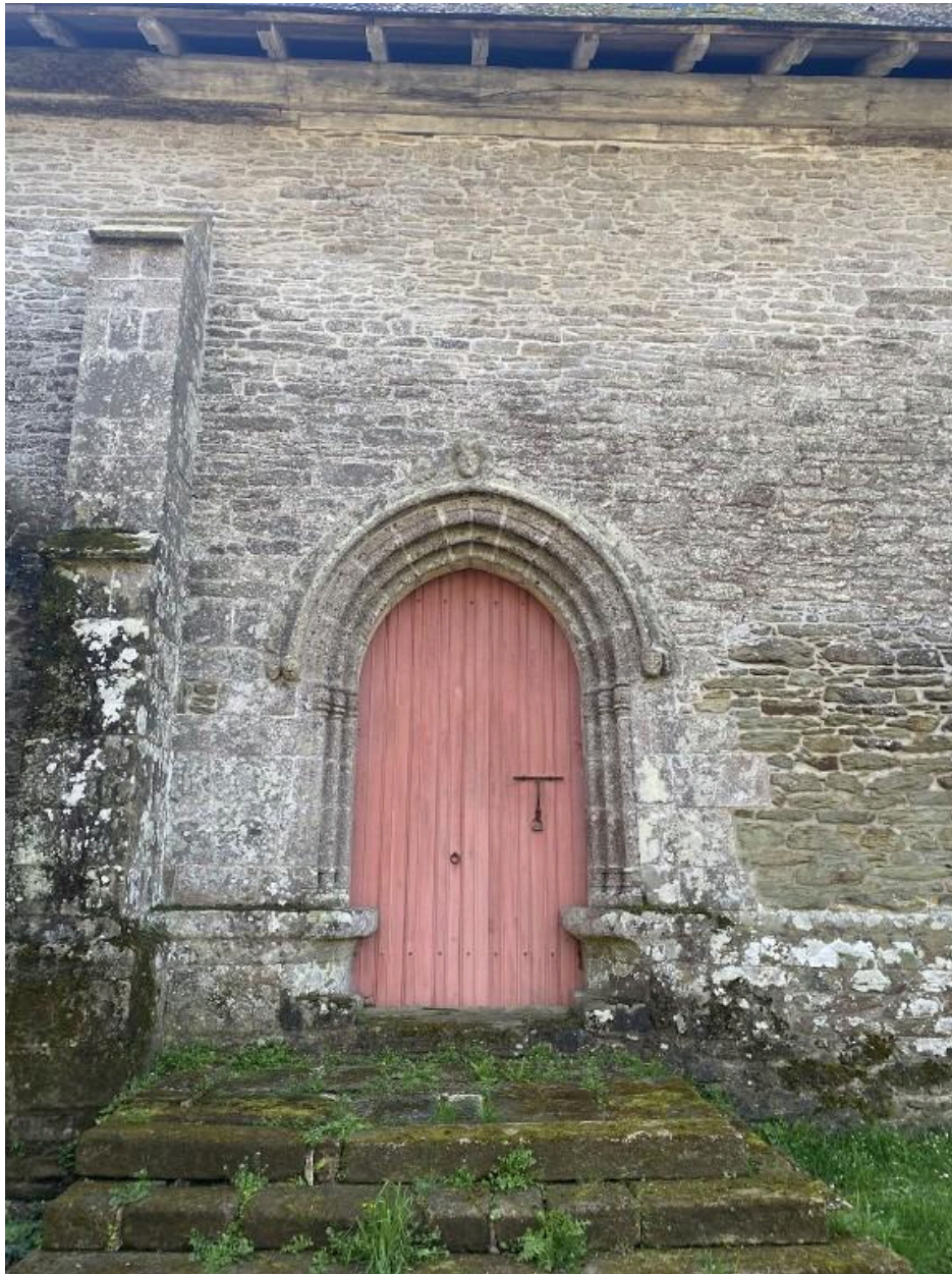
Porte, élévation nord
