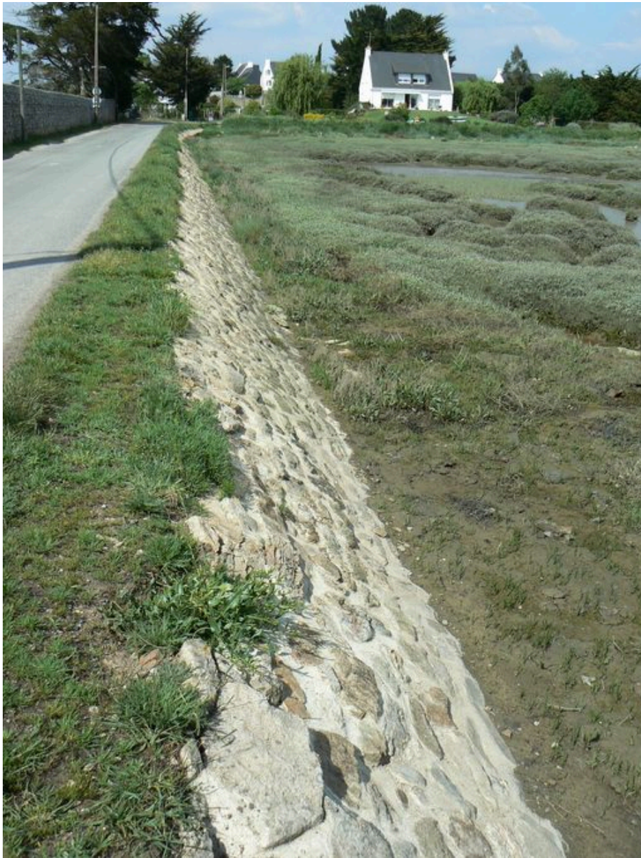
Digue-route du Passage Saint-Armel
