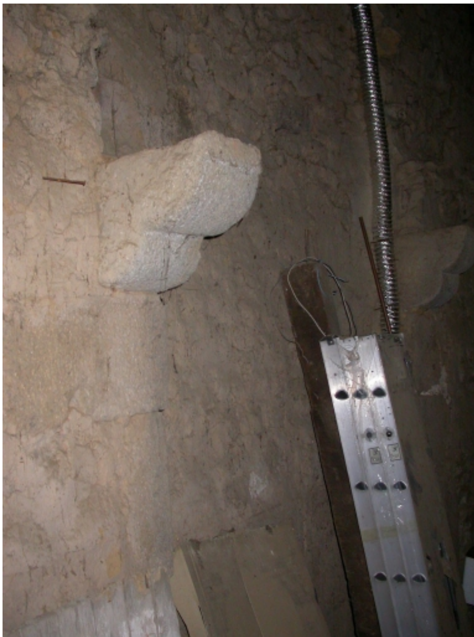
Corbeau de la cheminée de l'étage
